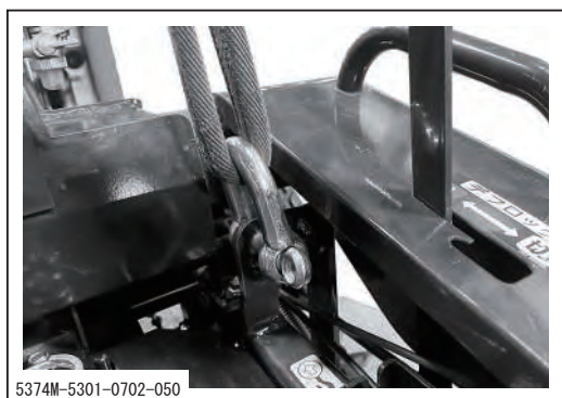
シャックル取り付け状態（左側）
